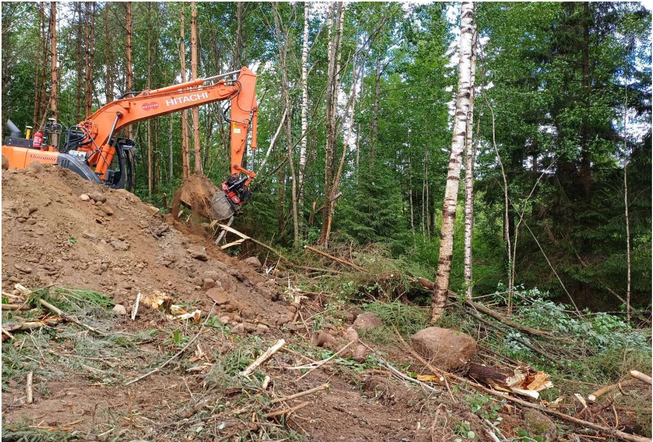
Kuva 1. Koekuopan KK11 kaivua.
